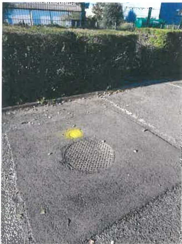
Vanne en face logistique. V3
